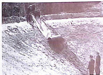
Bild 4. Tätningspresenningen rullas ner för ena slänten.
