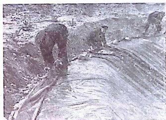
Bild 6. Tätningspresenningen "säkras" provisoriskt genom påläggande av stenar utmed kanterna.
