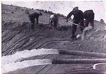
Bild 8. Så är det dags att börja påfyllningen av vatt-net. "Överbliven" personal sysselsätter sig med att täcka över presenningskanterna med jord.
