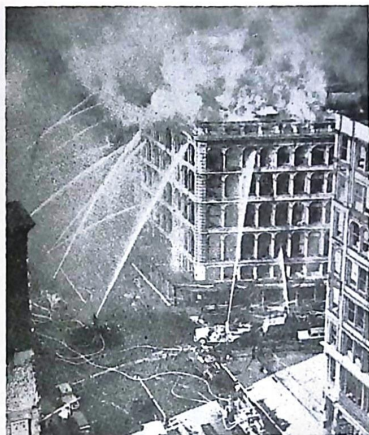
Bild 3. Wanamakerbranden invid Broadway i New York i det för rivning utrymda varnhuset. Vattenskadorna i byggnaden ansågos betydelselösa — men vattnet hamnade i den underjordiska järnvägens tunnlar och stationer.
