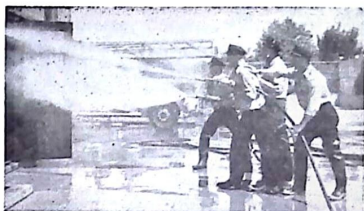
Bild 6. En jämförelse mellan olika högtrycks-vattendimstrålar. Den bortre är en s. k. penselstråle (alltså en sluten stråle) och den andra en till 30^\circ spridd stråle. Observera kastlängden för de båda strålarna.
