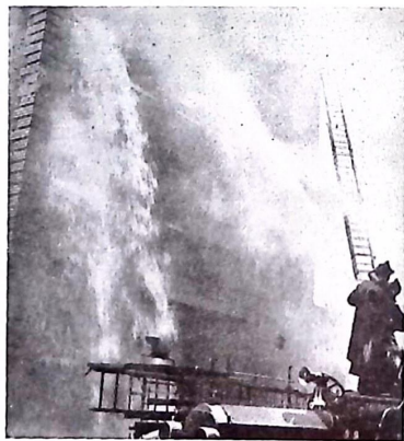
Bild 2. Här ser man hur vattenstrålar kastas in genom fönstren samtidigt som ett Niagara-vattenfall störtar ut genom ett annat.
