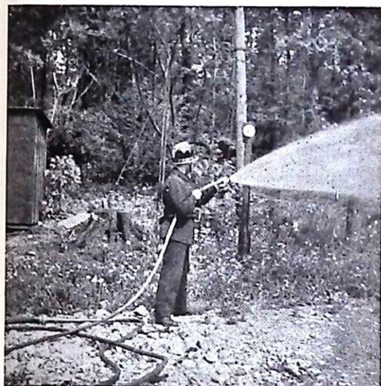
Bild 5. Det lilla Moblin-munstycket för finspridd vattenstråle anslutet till smalslang.
