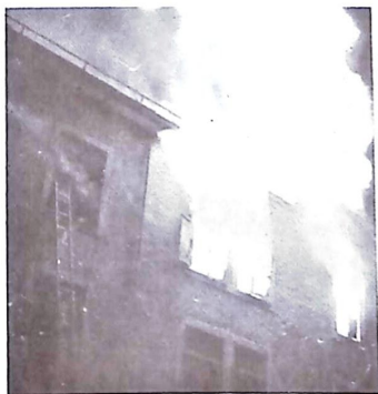
Bild 1. De övre våningsplanen övertändes först. De omkomna bodde i lägenheten vid stegen. Fastighetens östra fasad.
