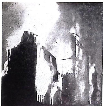
Bild 4. När fastigheten började stöta samman uppstod det mest kritiska skedet. Den närmast ligande fastigheten — av trä och 4 vdn. hög exkl. vind — antändes delvis.
