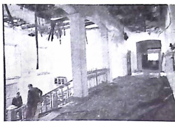
Bild 3. Övre trapphallen och korridoren efter branden.
