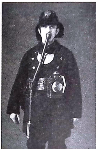
Bild 1. Brandfilter 1880. Observera filtrets låga placering.
