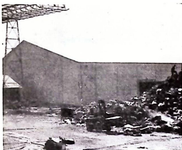
Bild 4. Östra gavelväggen av magasin B. Brandmurskonstruktionen framträder tydligt.
