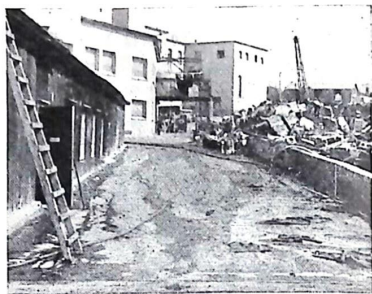
Bild 2. Det brunna området fotograferat från norra delen av kajen. Till vänster en av barackerna F, till höger rester av magasinet A.
