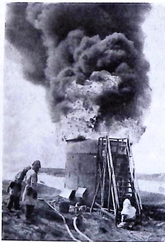
Bild 1. Försök med släckning enligt sub-surface-metoden (skum under ytan) pågår i den böga cisternen.
